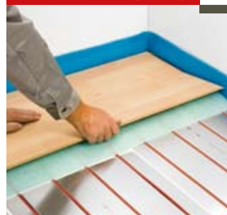
Instalace dřevěné podlahy
